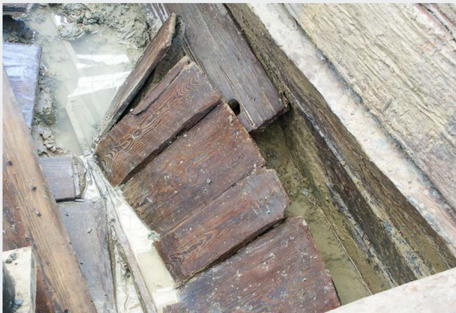
PORUŠENÁ STRECHA KNIEŽACIEHO POSMRTNÉHO DOMU V ČASE VÝSKUMU. FOTO: IVAN CHEBEN
